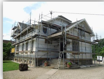
Ex. de mission SPS : Contrôle des échafaudages.
