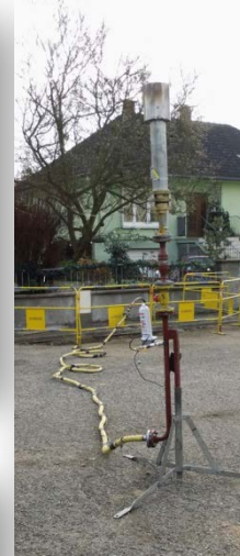
Purge des canalisations en bout de réseau après mise en place d'une torche
