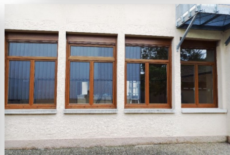
Pose de nouvelles fenêtres à l'école
