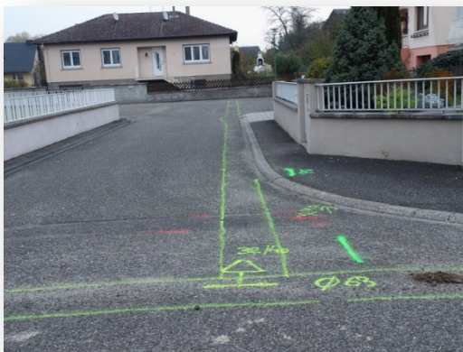
Le tracé des futures ouvertures de voirie.
