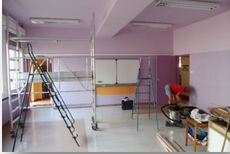
Finition après le passage du peintre à l'école
