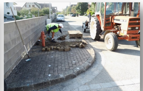
Travaux de voirie rue des Prés
