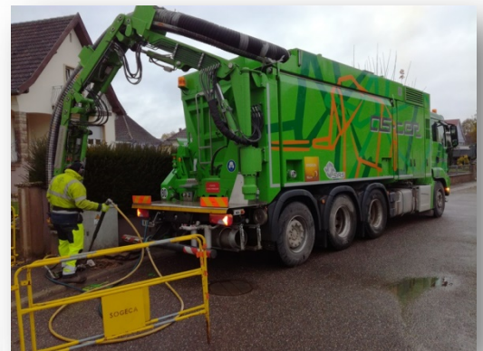
Travail par aspiration (sécurité pour les autres installations)
