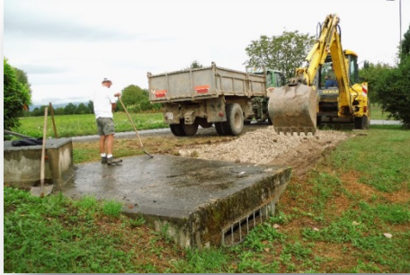
Décaissage avant la réalisation d'une dalle
