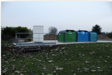
Apport volontaire nord : Dalle & garde corps
