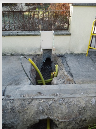
Pose du coffret de distribution
