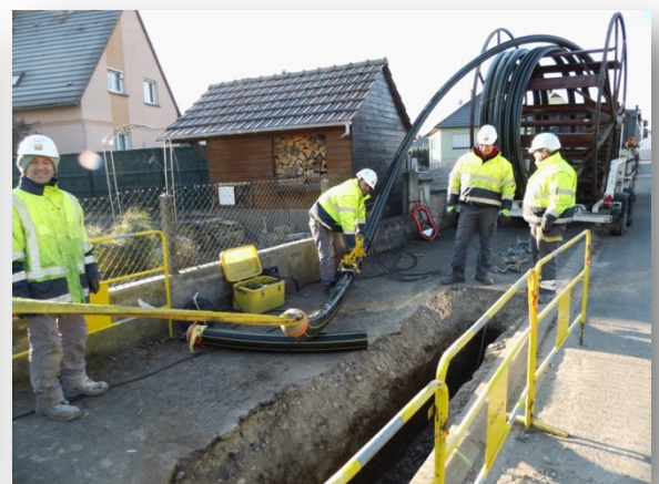
Préparation de raccordement entre 2 conduites
