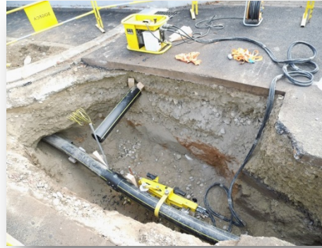
Redressement d'une conduite avant raccordement
