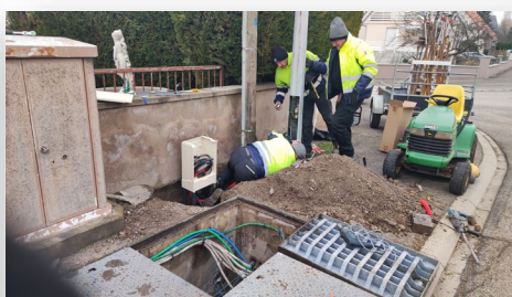
Passage des fourreaux rue Principale
