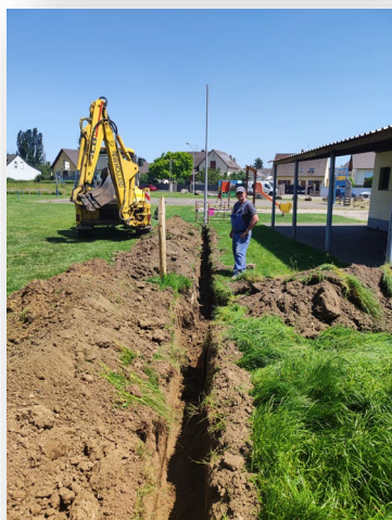
Génie civil à la salle polyvalente
