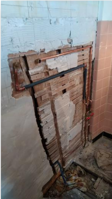
La salle de bain en pleine réfection
