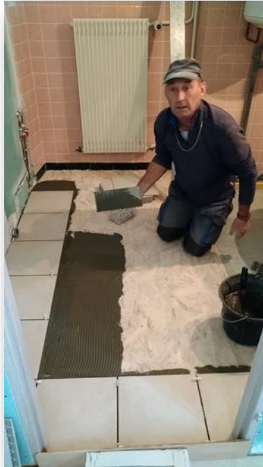
Carrelage après isolation
