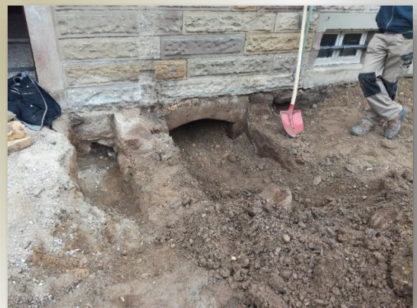
Découverte du puits d'évacuation des sanitaires
