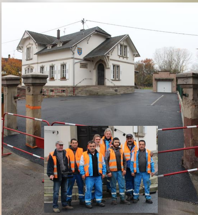
Bitumage terminé par l'entreprise VOGEL
